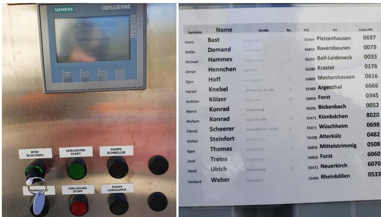
Abb. 9: Bedienelemente des Terminals mit Touchpad, RFID-Schlüsselloch und Bedienknöpfen (links), Liste der Landwirte mit individueller Code-Nr. (rechts)
