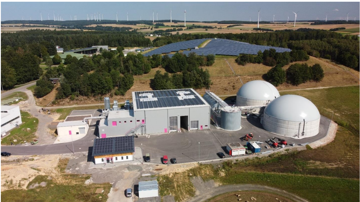
Abb. 4: Übersicht der Biomassevergärungsanlage auf dem Gelände der RHE in Kirchberg (August 2021)
