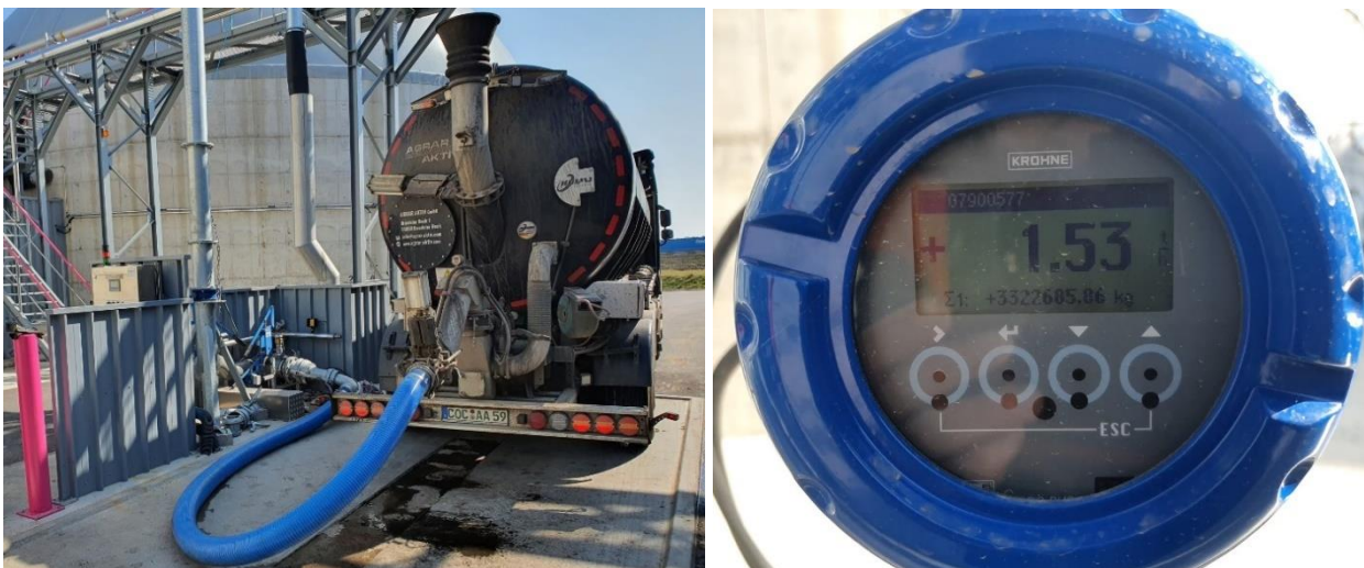
Abb. 7: Befüllstation (links) und geeichter Durchflussmesser (rechts) für die Verladung des Gärprodukts auf der Biomassevergärungsanlage
