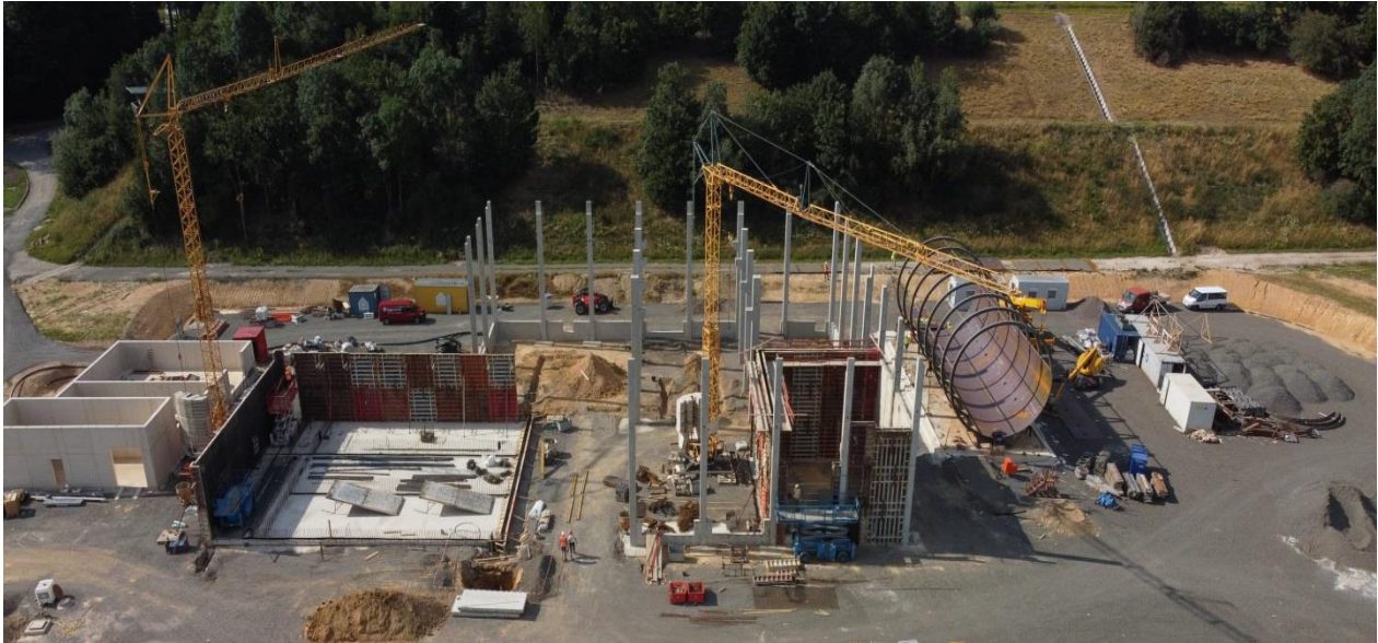
Abb. 3: Biomassevergärungsanlage der RHE im Bau (Juli 2020)
